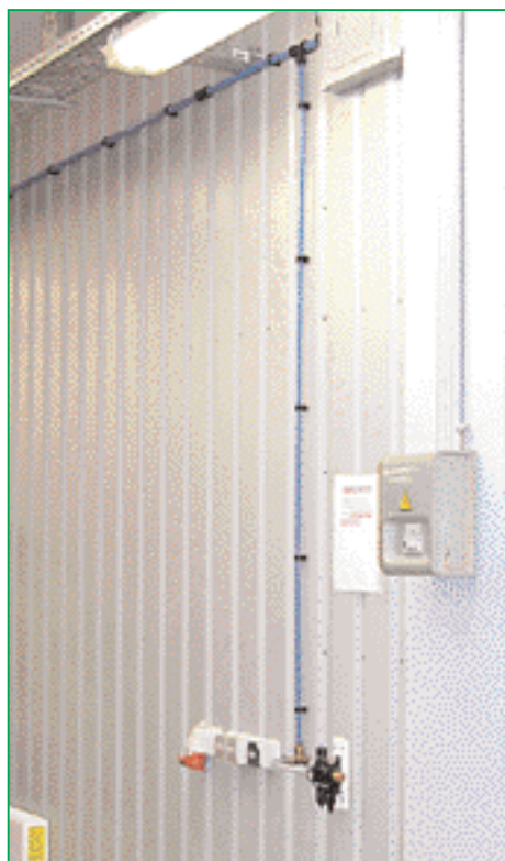
Пневмосеть, выполненная нейлоновыми трубами голубого цвета, с эстетической точки зрения безупречна.
