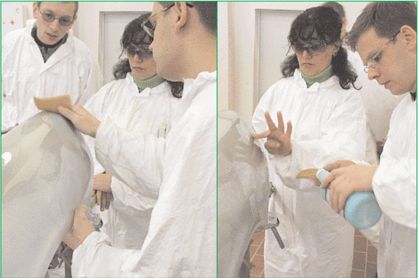
Приемы подготовки поверхности с использованием материала Scotch-Brite и матирующего геля отрабатываются на практике.
